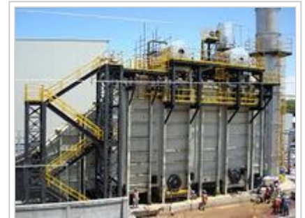
Industrial modular HRSG
